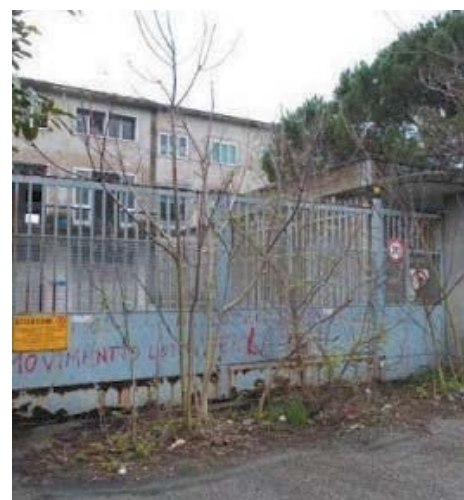
Degrado Lo stabile in stato di abbandono
